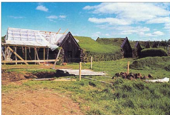
Langhuset på Keldur, Rangárvellir, er opprinnelig fra middelalderen og kan sies å være Islands eldste hus. Denne type torvhus trenger mye vedlikehold; torvveg-gene må bygges opp regelmessig, ofte med ca. 30-50 års mellomrom. Den tradisjonelle byggeteknikken på Keldur er svært viktig sett i forhold til eksempelvis spørsmålet om autenticitet. Alt repareringsarbeid og bruk av materialer må registreres grundig.
