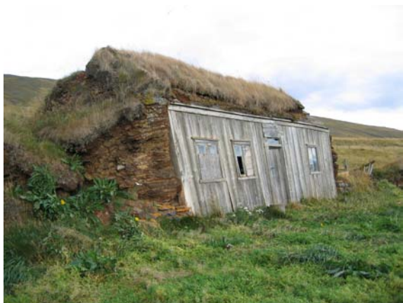
Tyrfingsstaðir á Kjálka, et viktig, representativt torvgårdskompleks, ble forlatt så sent som i 1969. Uten kontinuerlig vedlikehold og reparasjoner, vil slike bygninger gradvis forsvinne.
