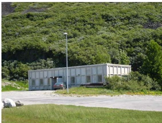
Karakteristisk blokkbebyggelse i Narsarsuaq, Grønland, bygget opp av betongelementer oppført av amerikanere under 2. verdenskrig.
