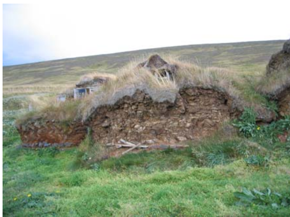
Den forlatte gården Tyrfingsstaðir á Kjálka, Island. Gården kan fortsatt reddes, eksempelvis ved å etablere et opplæringscenter for gamle byggeteknikker på stedet.
