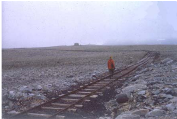
Togskinner skjærer gjennom det golde landskapet på Bjørnøya og binder sammen to deler av et kulturmiljø: Gruveanlegget Tunheim og havnen der kullskipene ble lastet.
