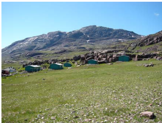
Nyoppførte turisthytter i Igaliku/Garðar, Grønland, hvor bedre planlegging kunne ha gitt en bedre tilpassning til kulturmiljøet. Den tette plasseringen er massiv og ødelegger balansen i forhold til den øvrige bebyggelsen.
