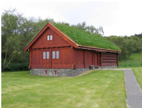
Audunarstofa på Holar i Hjaltdalur, Island. Hypotesekopi av biskop Audun den Rødes (biskop på Holar 1313-1322) bjelkehus som sto på Holar fram til begynnelsen av 1800-tallet. Huset sto ferdig i 2002. Ved bygging av rekonstruksjonen ble det tatt utgangspunkt i et rikt kildemateriale, men huset ble bygget dobbelt så stort som originalen. Slike eksperimenter med gammelt håndverk og redskap kan gi verdifulle opplysninger om bygningsteknikk i middelalderen.
